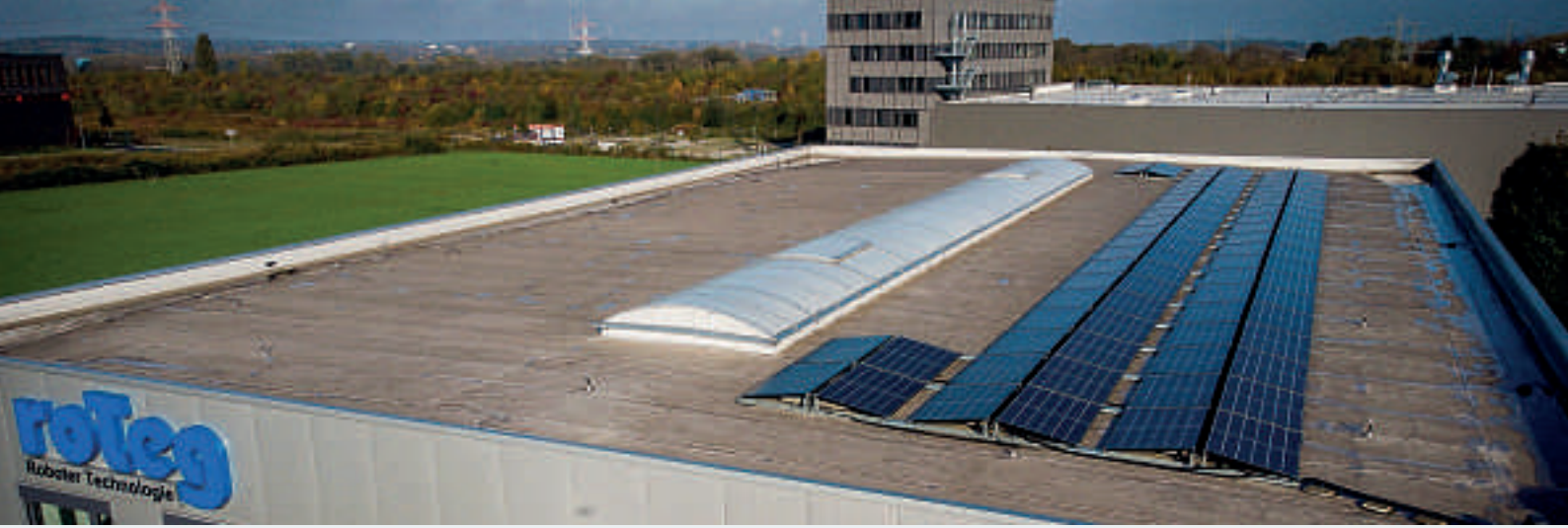
Die Solarstromanlage auf der Fertigungshalle der roTeg AG.
